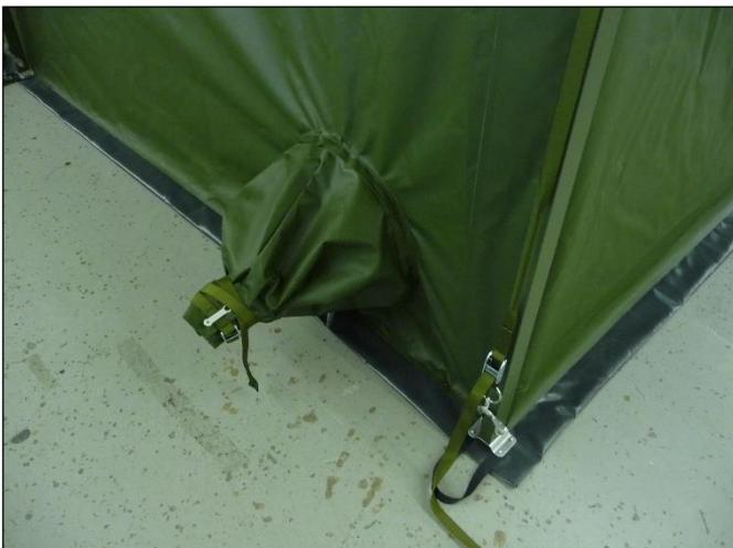
Fig 3.4.2 Heizrohrdurchführung
