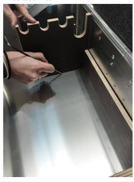
Die Umrisse des Holzeinsatzes mit der Reißnadel anreißen und die Bohrstellen für die Schrauben markieren.
